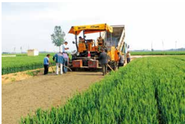
修筑田间道路
