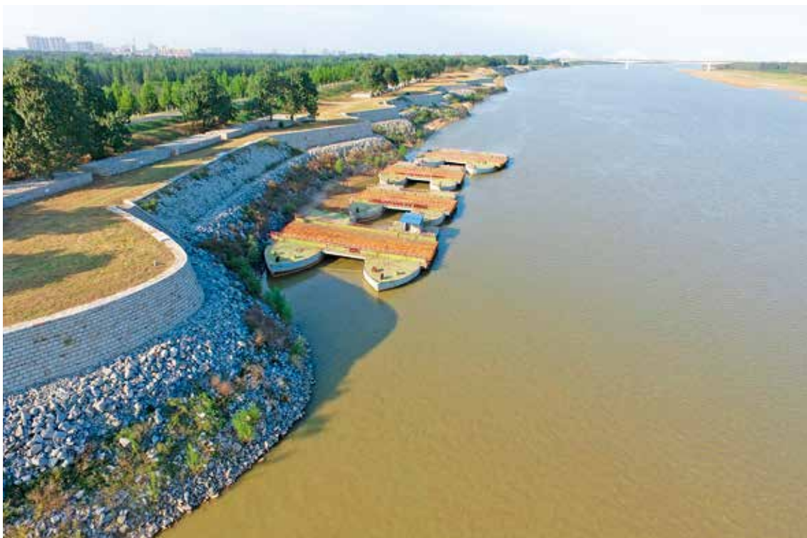
黄河济阳段沟杨险工
