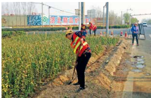
2016 年 3 月，对国道 G220 线与省道 S248 线交叉口绿化节点进行补植工作
