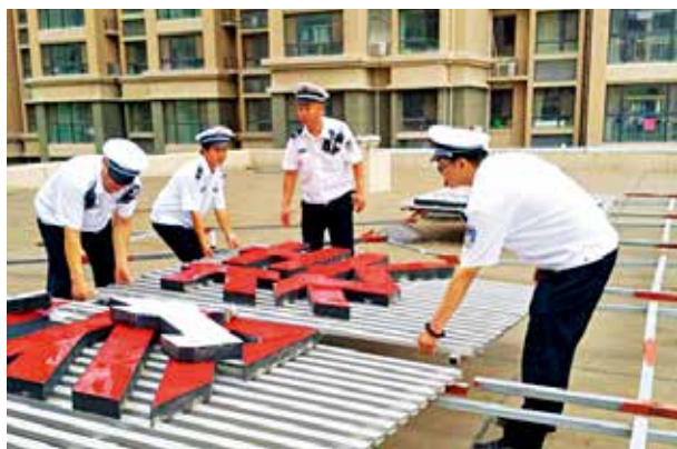
2016 年 7 月，对违规设置的大型户外广告牌匾进行拆除
