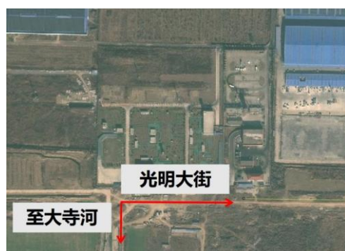
图 2.2-4 济阳区第二污水处理厂
