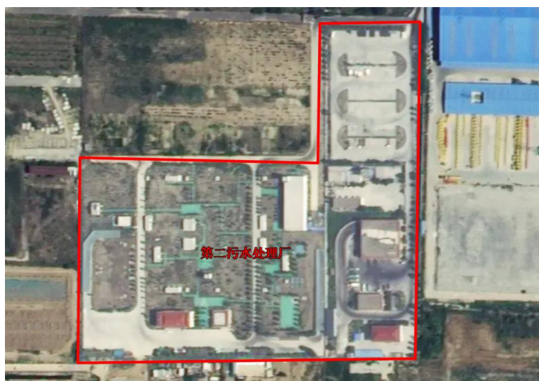
图 3.2-2 济阳区第二污水处理厂卫星影像图
