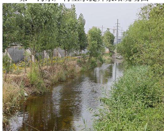
第一污水厂周边东干渠河道现状
