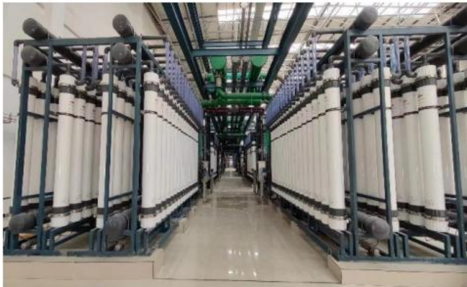
图 7.1-5 包头某高纯晶硅企业高盐水处理装置
