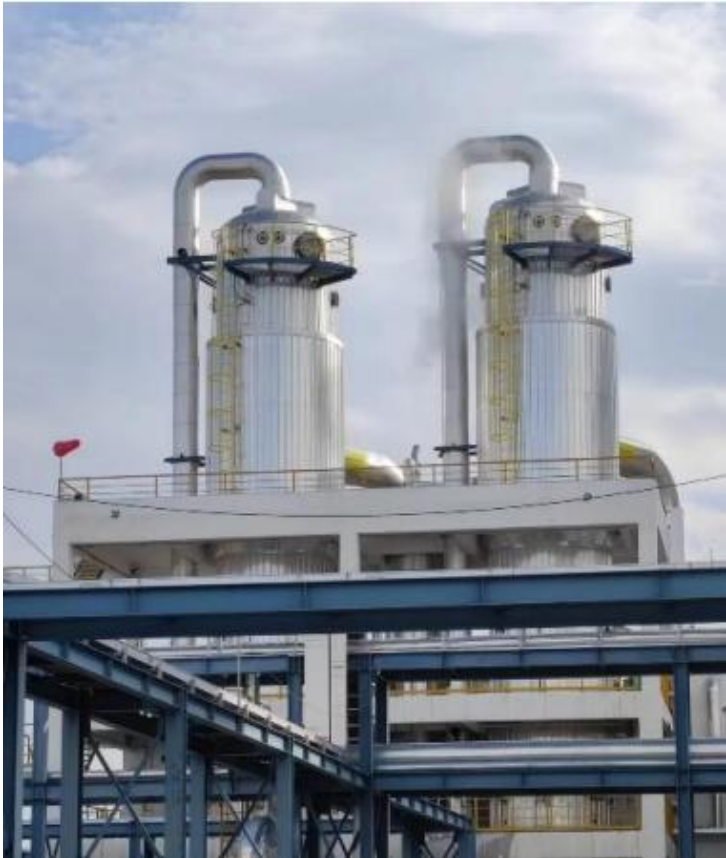
图 7.1-3 陕西某煤化工厂矿井水深度处理装置
