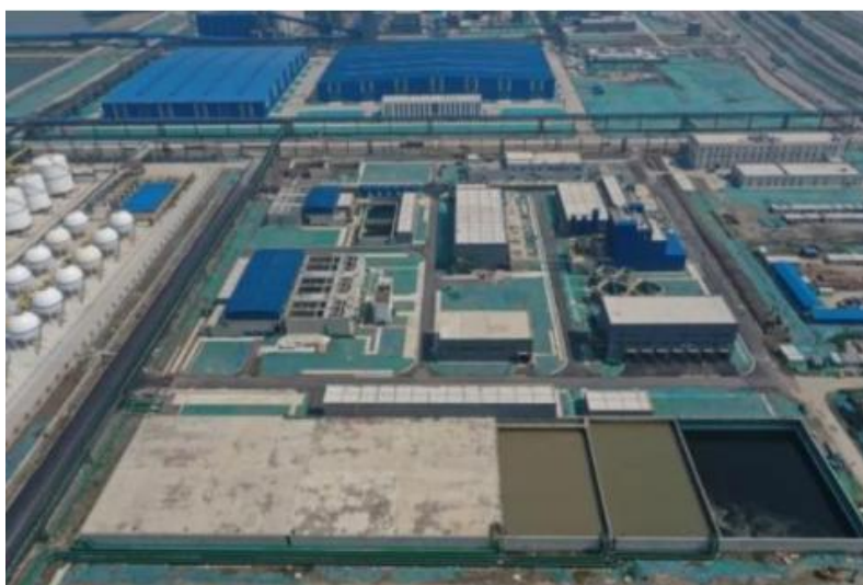
图 7.1-6 南通某钢铁企业“分盐结晶”废水零排放处理装置
