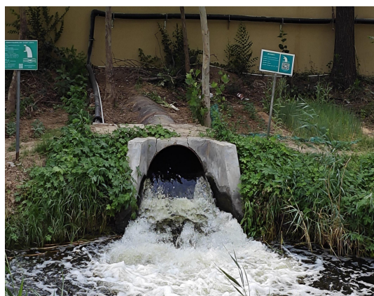
第一污水厂出水口流至东干渠
